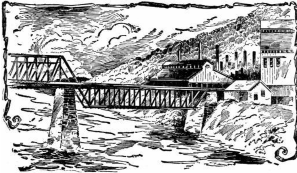
THE PEMICKEY BRIDGE.
